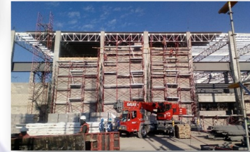
“AMPLIACIÓN PLANTA MALTA”. GRUPO MODELO MÉXICO, La Calera, Zac. OBRA CIVIL FASE 1
